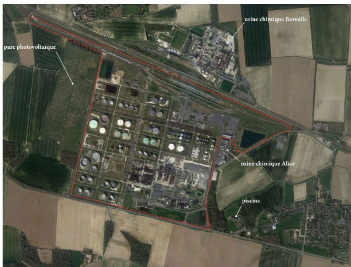
Figure 2 : Vue aérienne du site Industriel de Grandpuits avec, au nord, le falsceau ferré, et au sud la D619. En bas à droite de la photo se trouve le village de Grandpuits-Bailly-Carrois. Source : MR Ae d'après une Image Google Earth.
